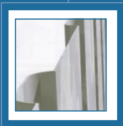
Mélyen bordázott, tűzi horganyzású lemezből készült tokszerkezet
