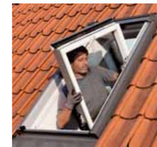
1. Eintreffen des Handwerkers Im Handumdrehen ist der Fensterflügel des alten Fensters ausgehängt.
