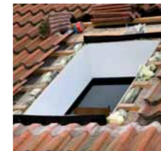
2. Altes Fenster ist ausgebaut Innerhalb kurzer Zeit ist das alte Fenster ohne Beschädigung der Innenverkleidung komplett ausgebaut.
