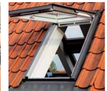
4. Austausch ist abgeschlossen Der neue Eindeckrahmen wird montiert und der Fensterflügel eingehängt. In nur wenigen Stunden ist der gesamte Fenstertausch durchgeführt.
